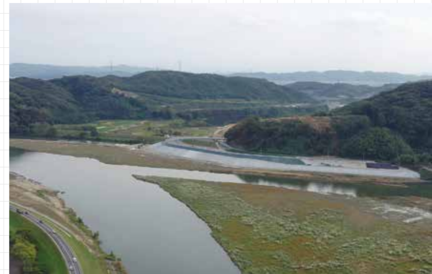
西日本水害後の小田川治水工事
